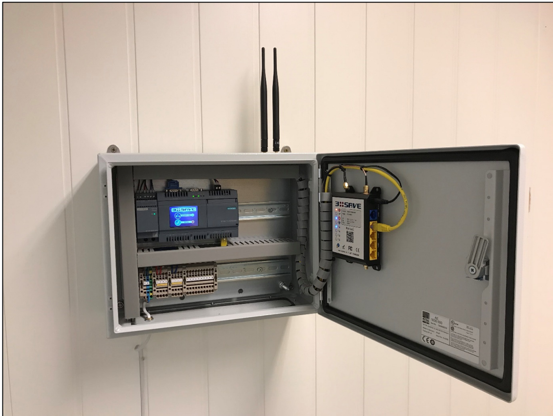
Esave IoT Logger, levert med skap og VPN Router
